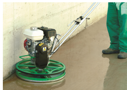
Esecuzione filo muro / Execution for thread
